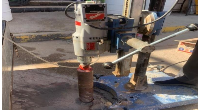
الشكل رقم (3) يوضح آلة الكور الكهربائية
